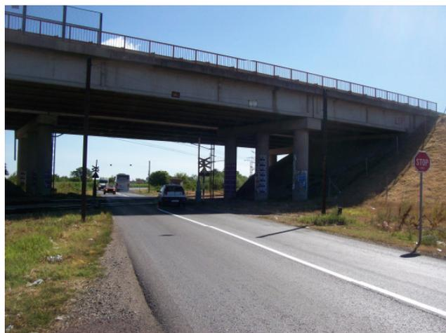
Interessant fand ich auch diese Brückenkonstruktion: um sich eine Autobahnbrücke zu sparen, hat man die Autobahn so gelegt, dass sie sowohl die Bahn als auch die Landstraße am gleichen Punkt überquert. Dass dadurch der unbeschränkte Bahnübergang genau im dunklen Schatten liegt und man die von der rechten Seite kommenden Züge nicht sehen kann, verursacht ja keine (unmittelbaren) Kosten...
